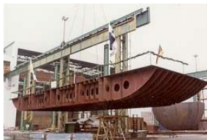
Der erste Block der „Homeri“ wurde am 29. August 1984 auf die Helling im Freien gelegt.
