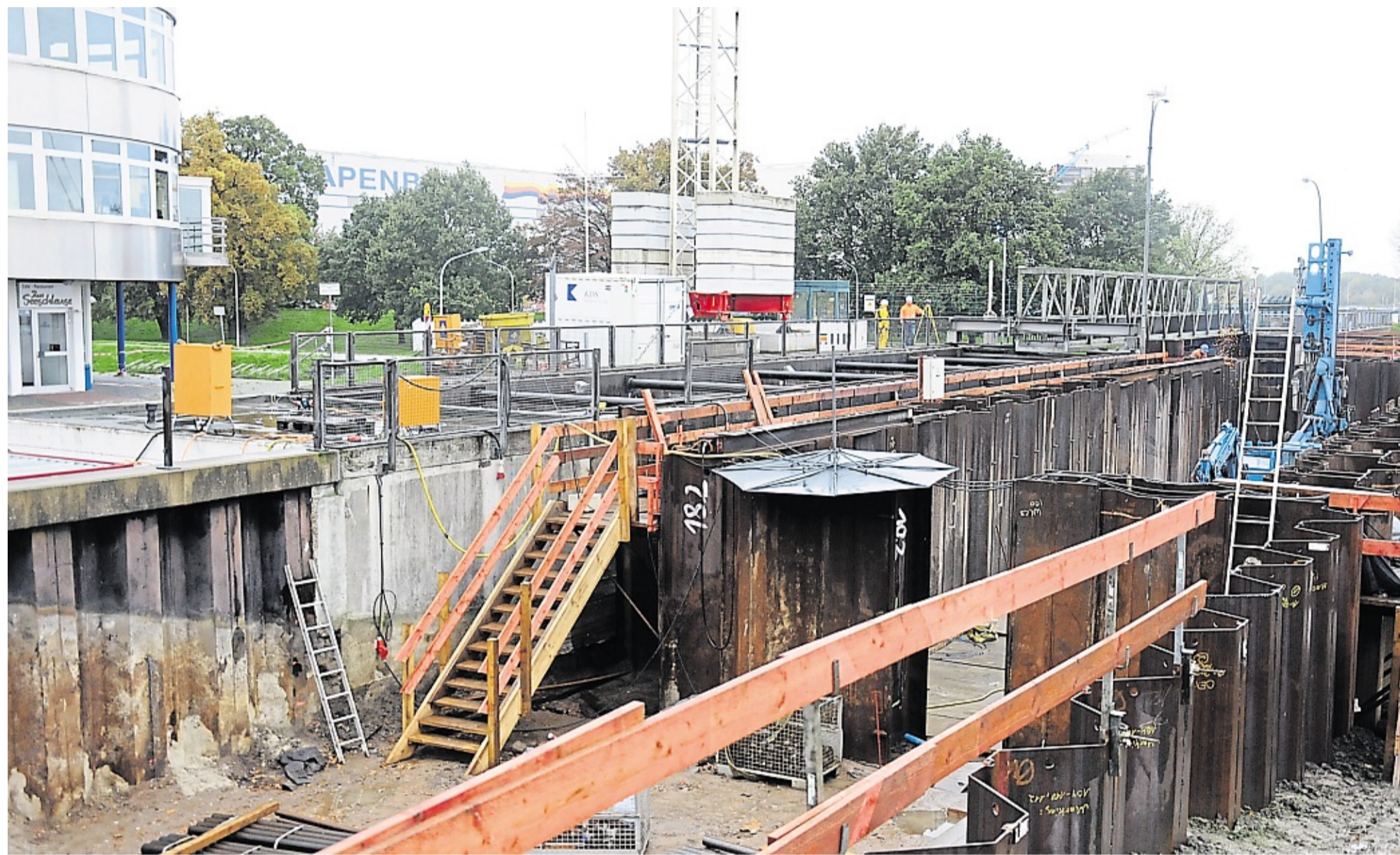
Aktuell laufen die Arbeiten des ersten Bauabschnittes zum Neubau der Seeschleuse mit der Erneuerung des Außentores.
