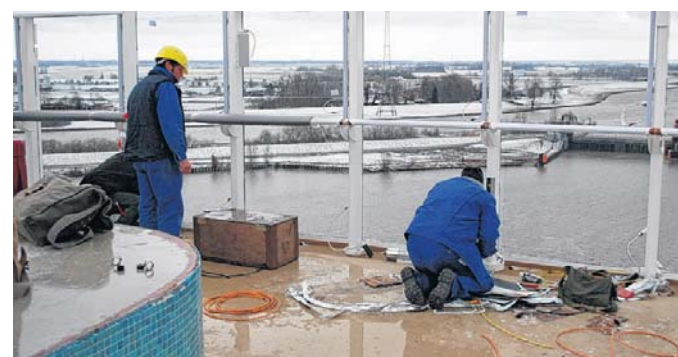
Arbeit bei Minusgraden mit Blick auf die Dockschleuse.
